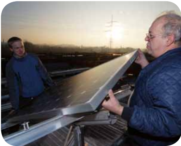
● Montage der Solarpaneele
