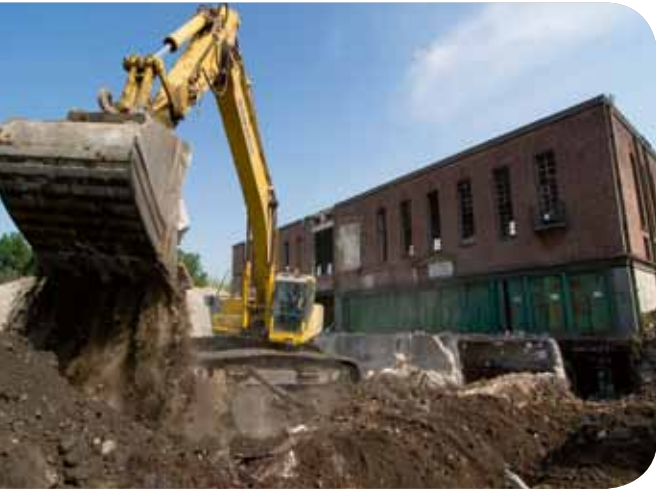
● Geländearbeiten für die Eingangsplätze
