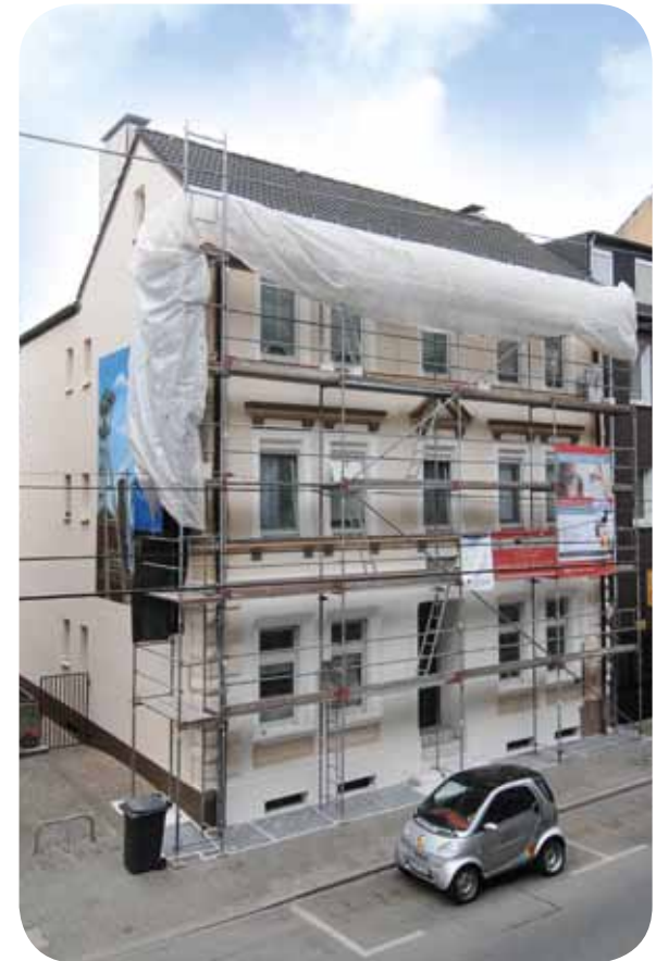
● Für Fassadenrenovierungen gibt es Zuschüsse
