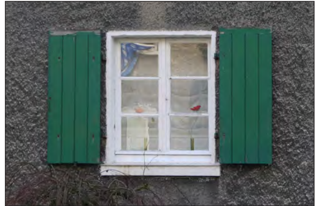
Abbildung 19 Fenster mit Klappläden und "echten Sprossen"
