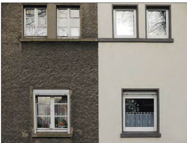
Abbildung 12 Links originale Spritzputzstruktur, rechts neuer strukturloser Glattputz
