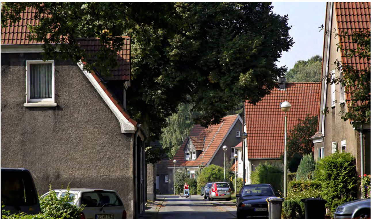
Abbildung 16 Dachlandschaft mit wenigen Einbauten und historisch belegter roter Eindeckung
