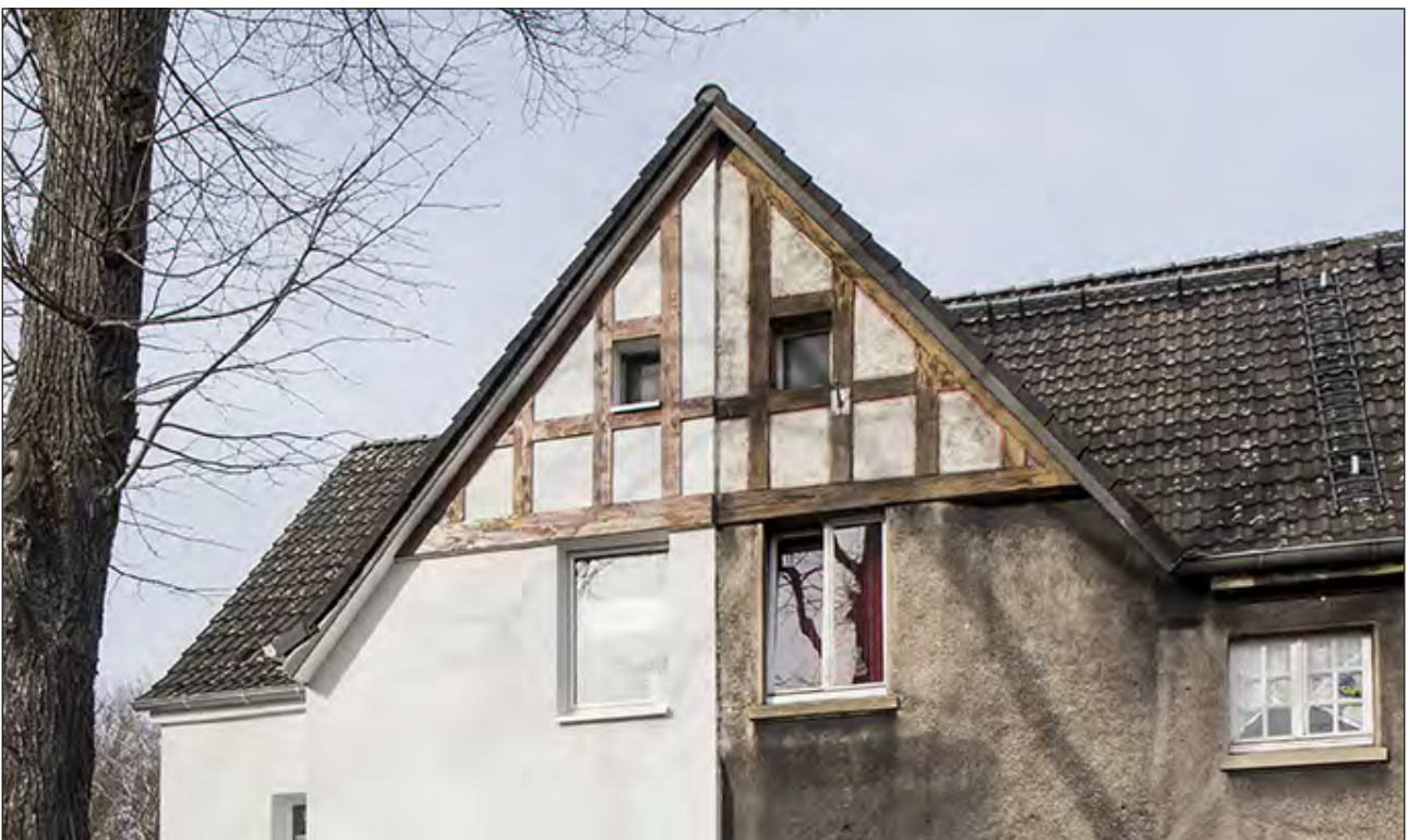
Abbildung 13 Ein auf der neuen Dämmung nachgezeichneter Fachwerkgiebel
