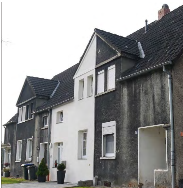
Abbildung 14 Nachbildung eines Gesimsbandes in WDVS
